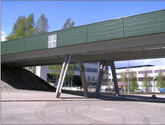
Kuva 3. Metron uusimmat melukaiteet ovat väärin päin: melua absorboiva reikäpelti + mineraalivilla on esteen ulkopinnoilla, kun sen pitäisi olla sisä- eli radan puolella!
