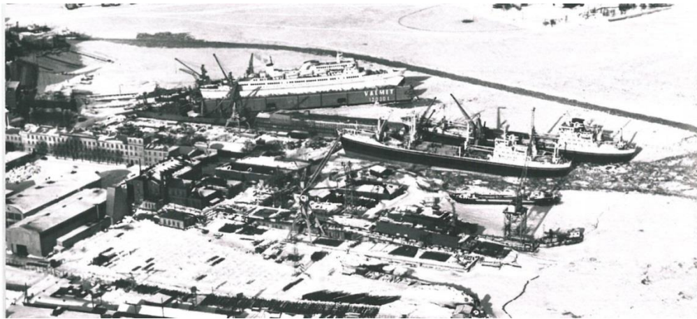
Kuva 9. Ilmakuva Valmetin telakka-alueelta vuodelta 1969. Kuva skannattu teoksesta Maata Näkyvissä, Helsingin maanhankinnan viisi vuosisataa (Yrjänä 2013). Kuvan alkuperäinen lähde: Jorma Pohjanpalo.
