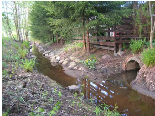
Kuva 9. Vartiokylän hulevesiviemäri. Kuva: Katja Pellikka.
