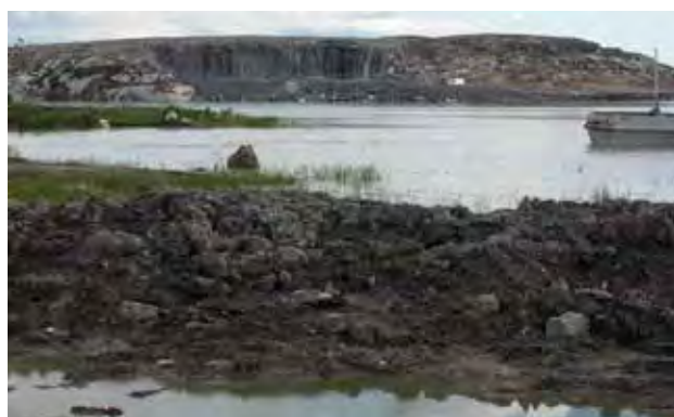
Kuva 24. Käärmeniemi vuonna 2004, kun satamaa jo rakennettiin ja Käärmeniemen kallioon oli louhittu haitallisia aineita sisältävien sedimenttien sijoitusvarasto.
