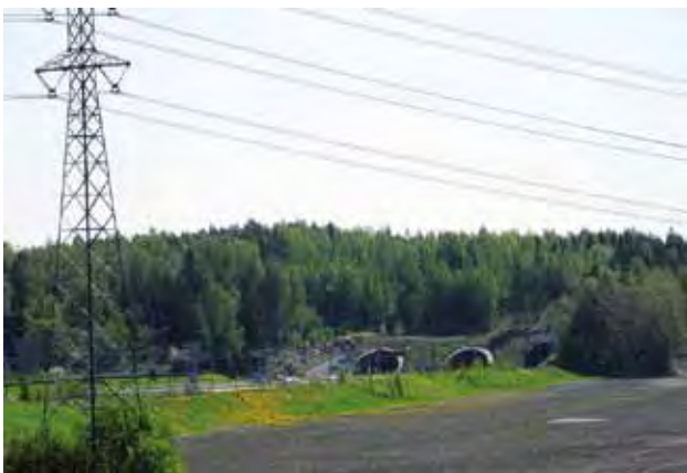
Kuva 26. Österängenin vuonna 2012, tietunnelien suuaukot Labbackan pohjoisrinteessä.
