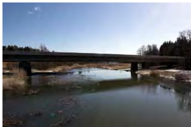
Kuva 32. Porvarinlahden kapeikko vuonna 2007, kun rautatiesilta on valmistunut, mutta mm. johdotus puuttuu vielä.
