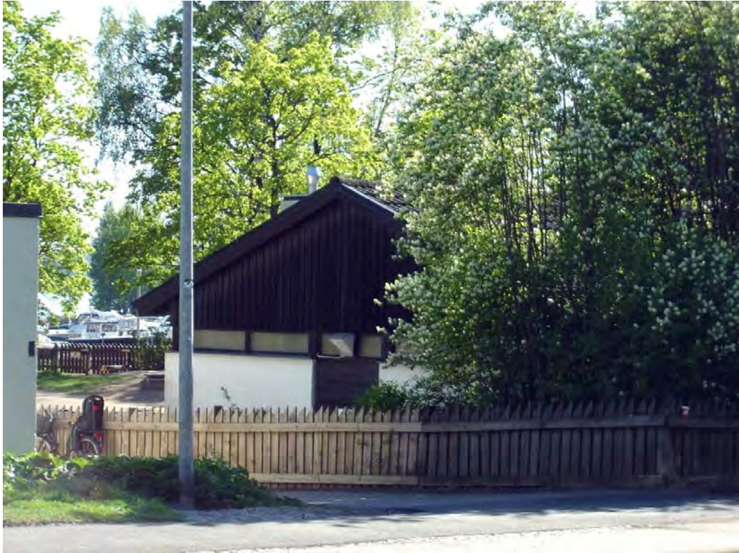
Kuva 8. Rajasaarentien jätevesipumppaamo. Kuva: Paula Nurmi.
