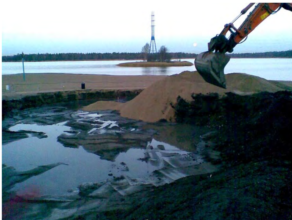
Kuva 2. Hietarannan vanhan kaatopaikka-alueen kunnostustyö. Kuva: Päivi Seppänen / Golder.
