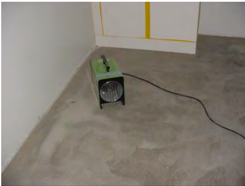
Kuva 9. Asunnon sisälämpötilaa nostettiin sähkölämmittimen avulla.
