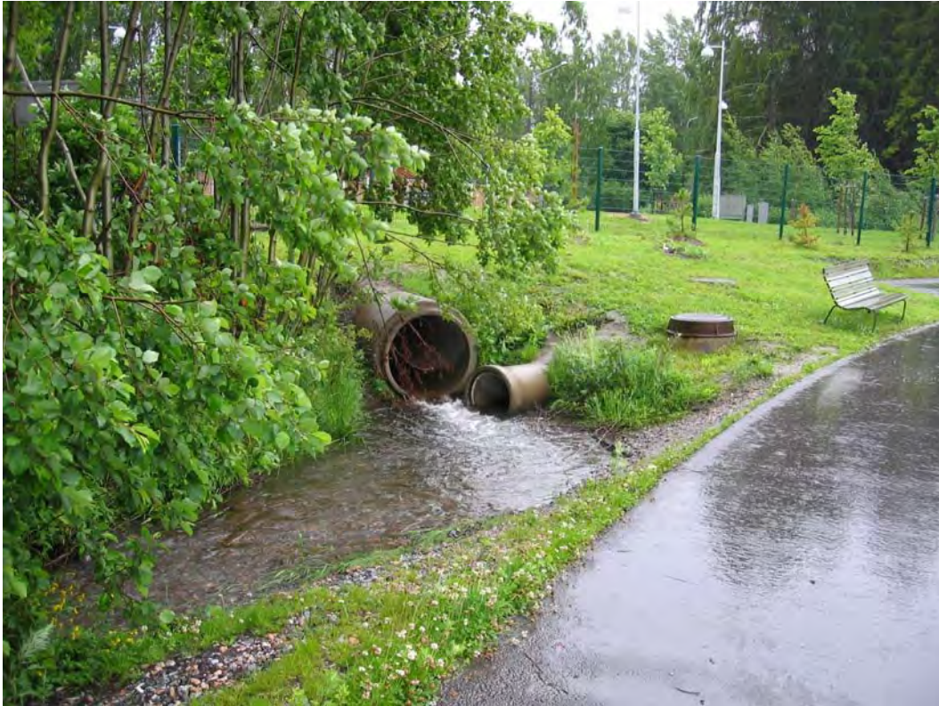
Hulevesiviemäreitä Talissa. Kuva: Helsingin kaupungin ympäristökeskus.
