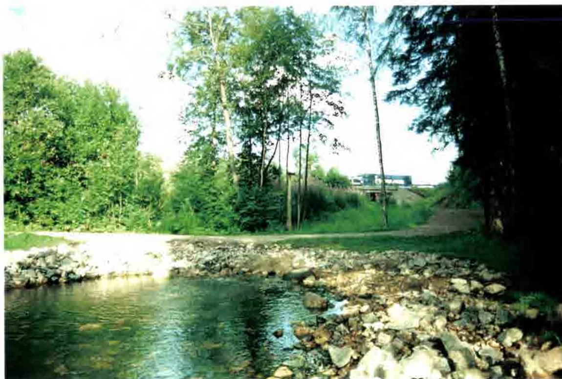
Kuva 74. Veden lisäjuoksutusta Mätäjokeen. Juoksutusputken pää näkyy kuvan keskellä. Taustalla Hämeenlinnan väylä.
