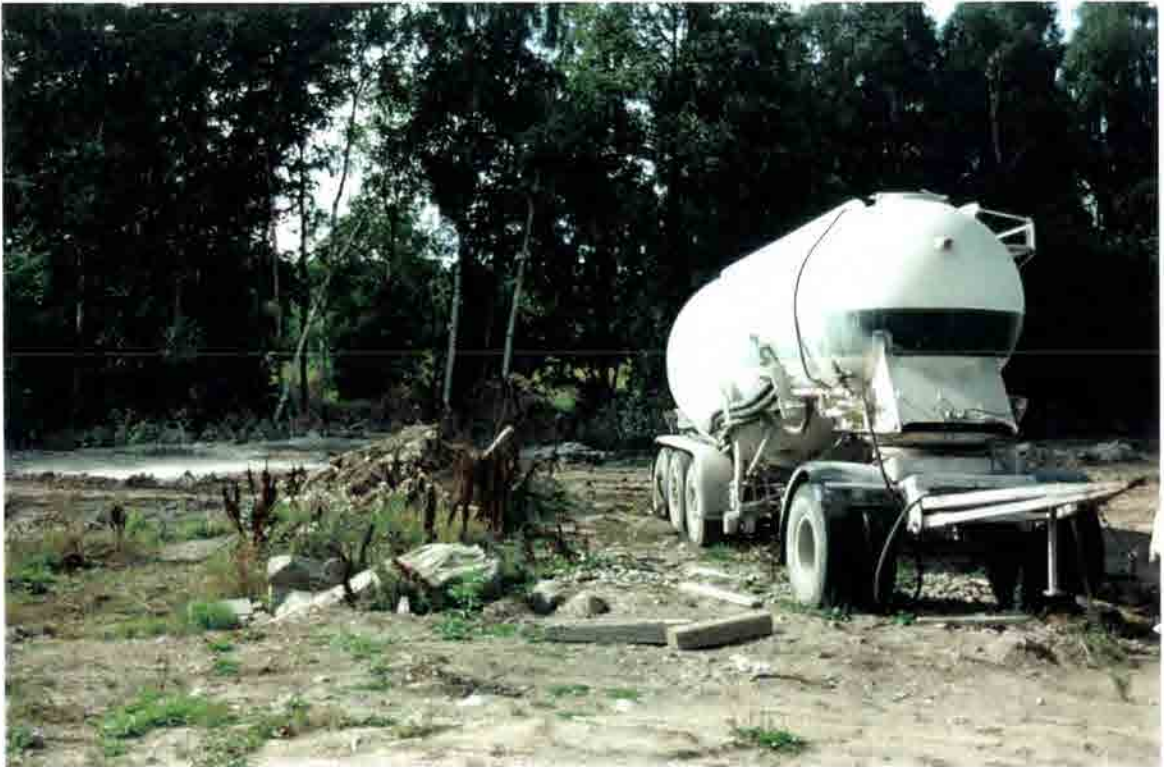
Kuva 75. Rakentaminen voi olla uhka Mätäjoelle. Savikkoa lujitetaan kalkilla Talissa kesällä 1997. Mätäjoki virtaa takana näkyvässä metsässä.
