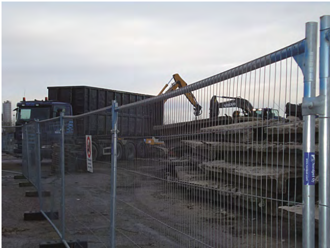
Kuva 1. Purkujätettä lastaamassa. Kuva: Jukka Puttonen.
