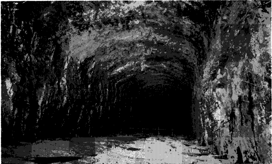
Vanhankaupungin laitoksen peruskorjauksen yhteydessä louhittiin puhdasvesialtaat kallion sisään Jokiniementien länsipuolelle. Kuvassa keskimäinen kolmesta allasluolasta, joiden yhteinen vesitilavuus on 56 000 m 3 . Luolan pituus on 135 m, leveys 15,5 m ja keskikorkeus noin 12,5 m.
