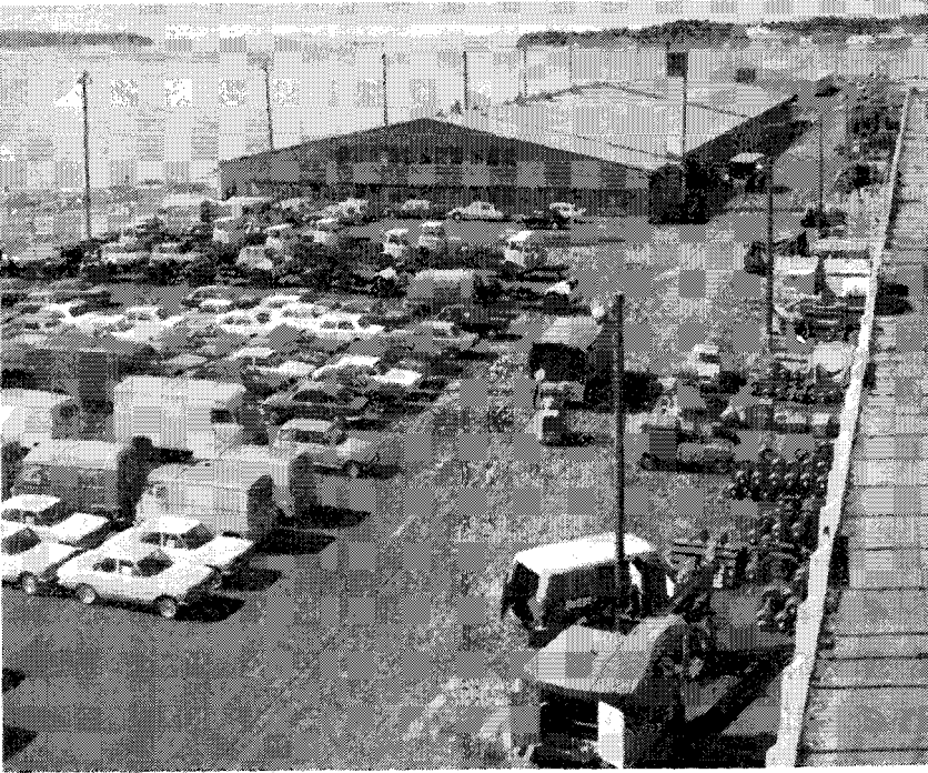
Vapaavarastorakennus V I
