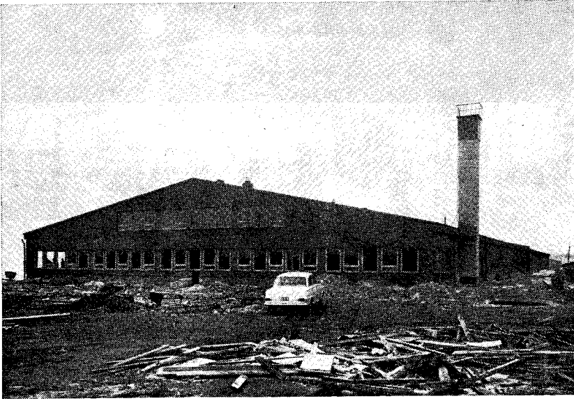
Vapaavaraston tiloja rakennusvaiheessa
