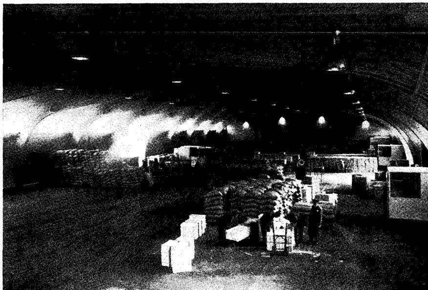
Sisäkuva Matkustajalaiturin uudesta varastorakennuksesta.
