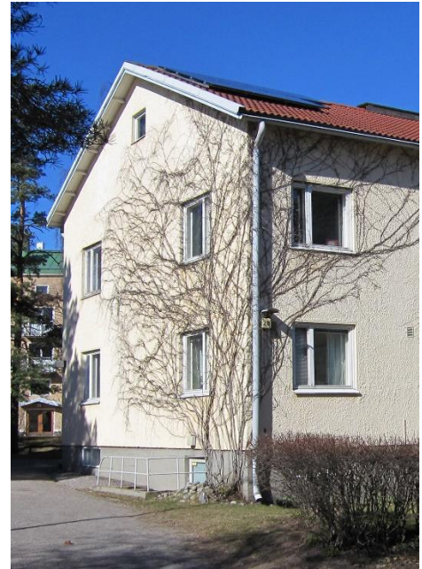
Herttoniemeläisen asuinkerrostalon katolle on asennettu aurinkopaneeleita
