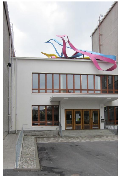
Käpylän koulun peruskorjauksessa parannettiin sisäilman ja esteettömyyden lisäksi energiatehokkuutta
