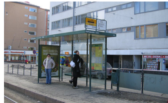
Pysäkkikatokset, Jokeri-katokset ja taksikatokset.
