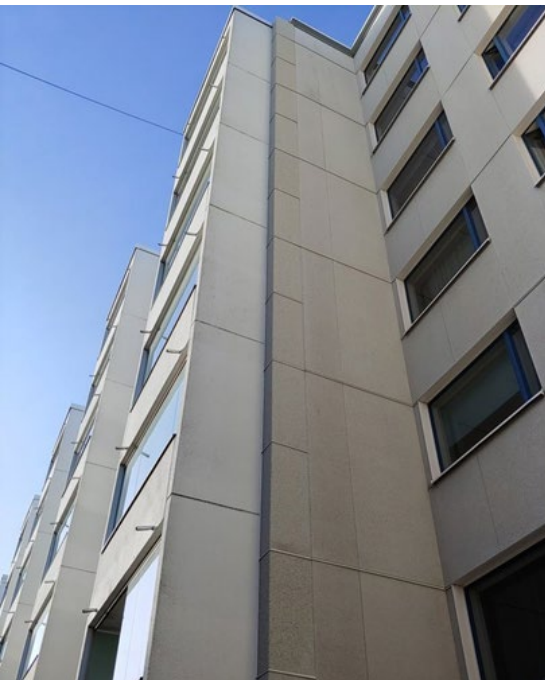
LTO-putkia Punavuoressa. Vastaava sijoitus ei edellytä rakennusvalvonnan lupaa.
