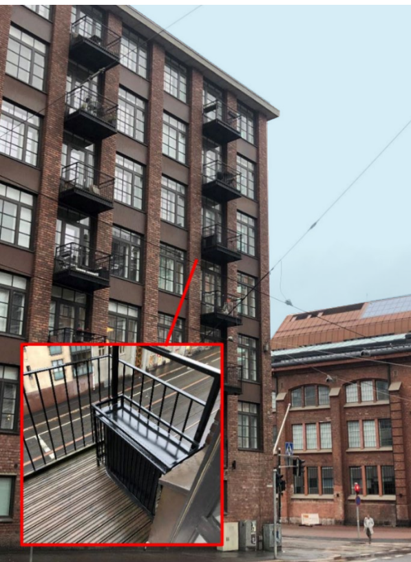
(Yllä) Munkkisaarenkatu 2A ilmalämpöpumpun ulkoyksikkö on sijoitettu huomaamattomasti pinnakaiteen sisäpuolelle. Sijoitus ei edellytä rakennusvalvonnan lupaa. Huomioitava, ettei laite saa synnyttää mahdollisuutta kiipeämiselle.
