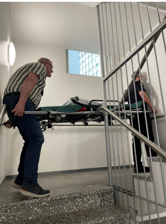
Kuva 2: Paarin pituus aisat ulkona on n. 2400 mm. Kantajat eivät mahdu tähän pituusmittaan, kun paareilla on potilas ja kantajien selässä välineistöä. Kun paareilla on painoa, aisojen säätäminen kannettaessa on työlästä. Lepotason leveys kuvassa on 2500 mm.
