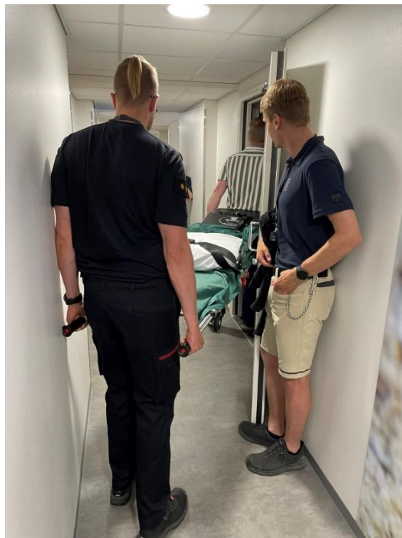
Kuva 5: Käytävää kaventava hormi estää kääntymisen täysin. Käytävän leveys on tässä kohtaa 1200 mm.
