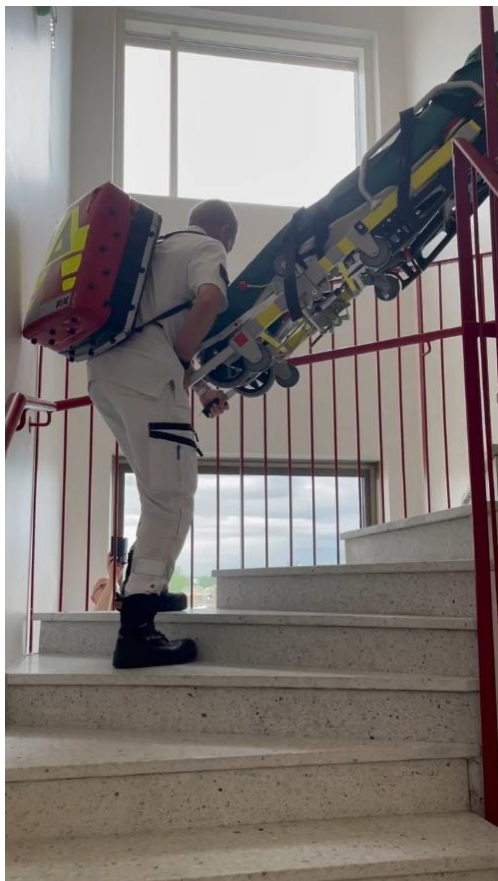
Kuva 2: Paarin pituus aisat ulkona on n. 2400 mm. Kantajat eivät mahdu tähän pituusmittaan, kun paareilla on potilas ja kantajien selässä välineistöä. Kun paareilla on painoa, aisojen säätäminen kannettaessa on työlästä. Lepotason leveys kuvassa on 2500 mm.
