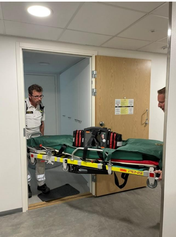
Kuva 4: Kääntyminen asunnosta 10 M ovesta 1500 mm leveälle käytävälle. Avattu ovilevy kaventaa käytävän leveyttä lisäksi n. 70 mm. Kääntyminen onnistuu vain kahvoja sisään vetämällä (oikealla) ja kantajien siirtyessä sivuun parien päistä.
