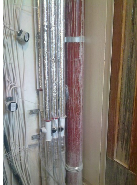
Uudet KVV-putkistot asennettuna porrashuoneeseen. Sähkö- ja telekaapeleiden tilantarve on lähes sama kuin KVV-putkilla. Kuva: Tomi Marjamäki
