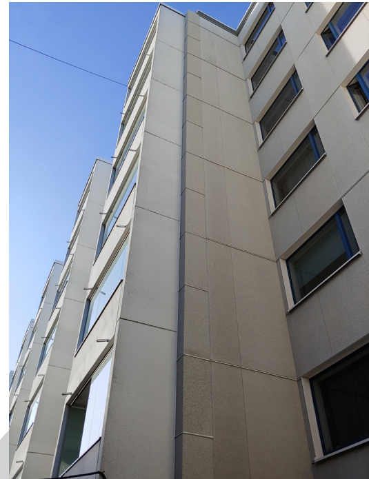
Poistoilmalämpöpumpun putket voidaan tehdä myös rakennuksen ulkopuolelle. Kuva: Juha Likonen
