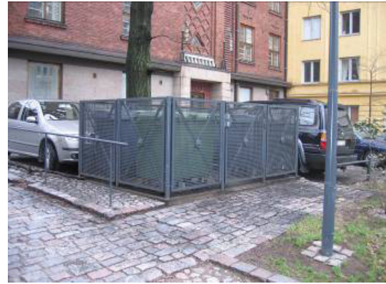
Arvoympäristöön sijoitettu jätesuoja.
