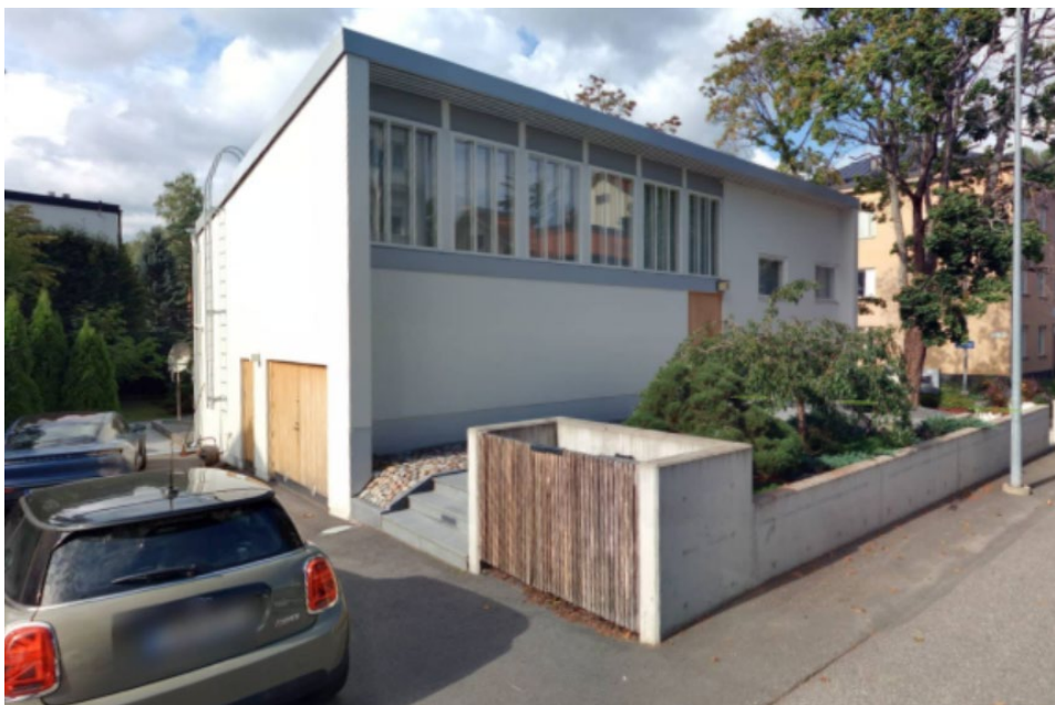
Kuva 3. Hienosti talon arkkitehtuuriin sovitettu jäteaitaus. Nuottapolku 8, Helsinki.
