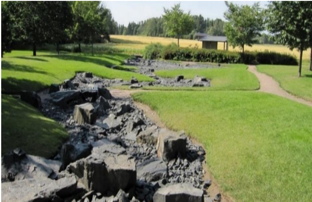
Kuva 1. Hulevesien viivytyksrakenne Eko-Viikissä.
