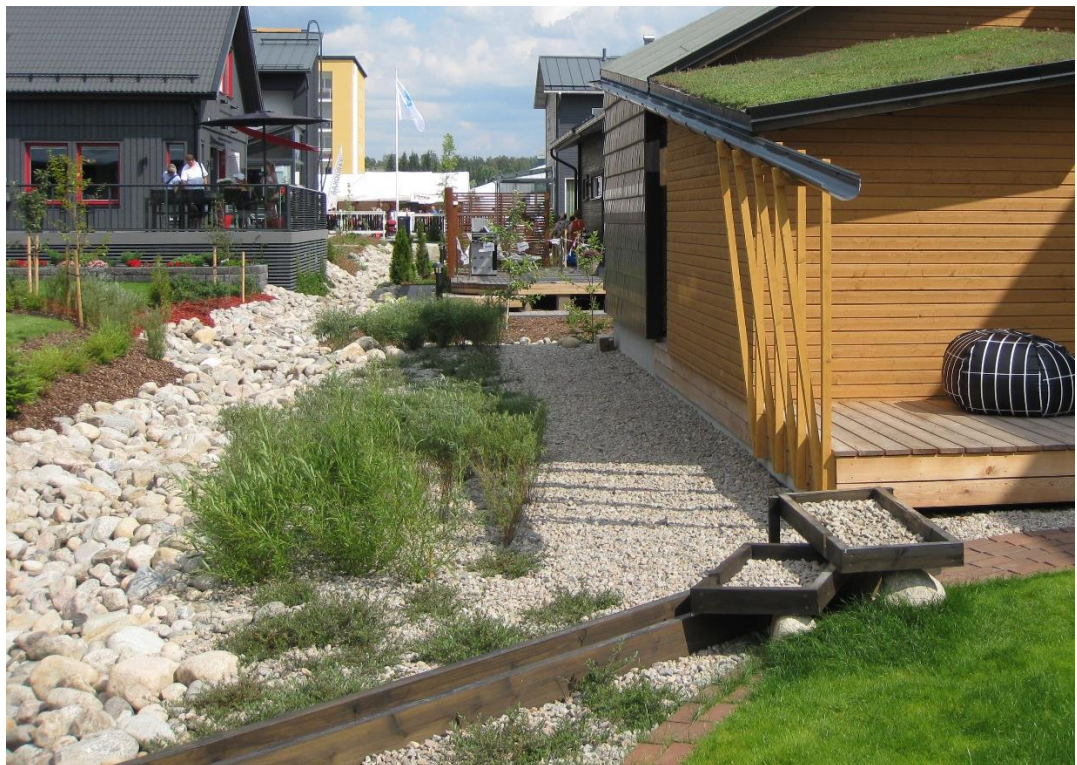
Kuva 3. Esimerkki hulevesien hallintajärjestelyistä Jyväskylän asuntomessualueelta.
