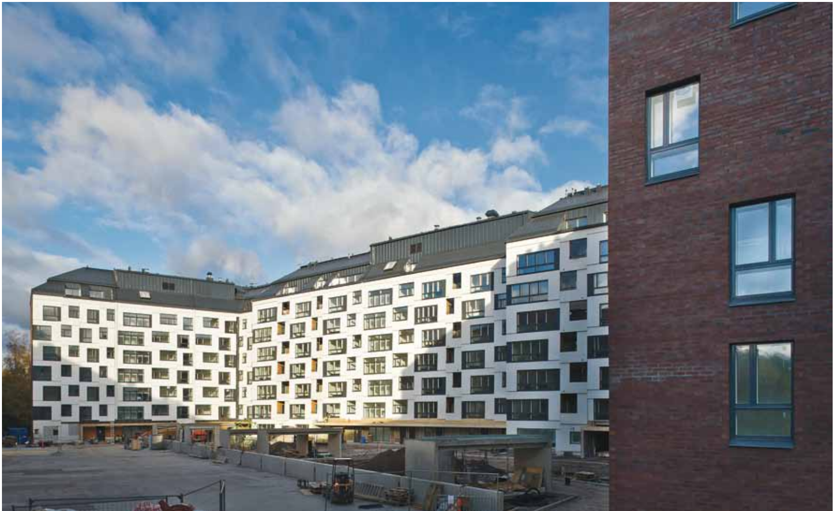
ASUINKERROSTALO KAANAANPIHA 4 BOSTADSHÖGHUSET KANANSGÅRDEN 4 APARTMENT BLOCK KAANAANPIHA 4
