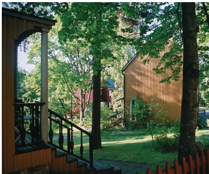
yllä: pihanäkymä Puu-Käpylästä vasemmalla: julkisivupiirroksia Pohjolankatu 23, Puu-Käpylä
