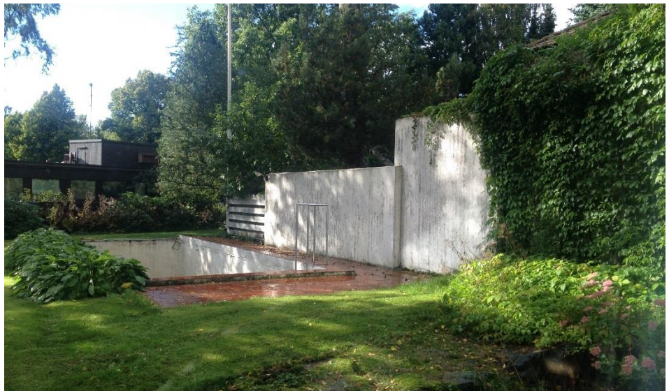
Rakennusten välinen tukimuri runsaine istutuksineen kuvattuna purettavaksi aiotun 1960-luvun rakennuksen olohuoneesta. (Kuva Leena Paavilainen)
