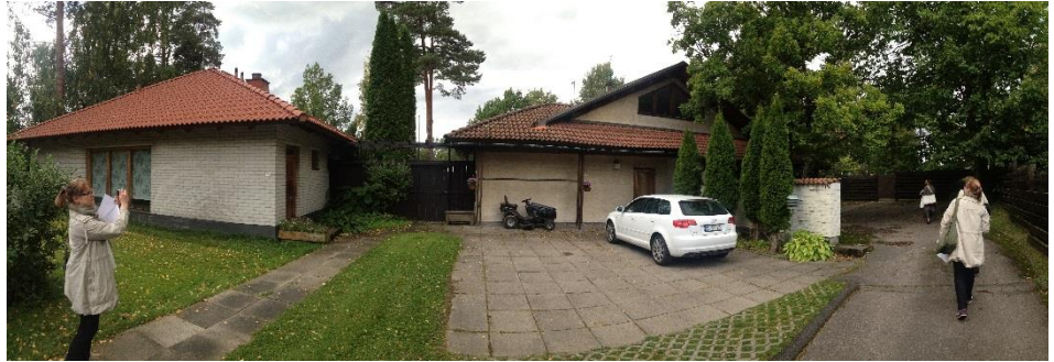
Vasemmallalla kuvassa 1960-luvulla rakennettu asuinrakennus, oikealla 1950-luvun talo. (kuva Leena Paavilainen)
