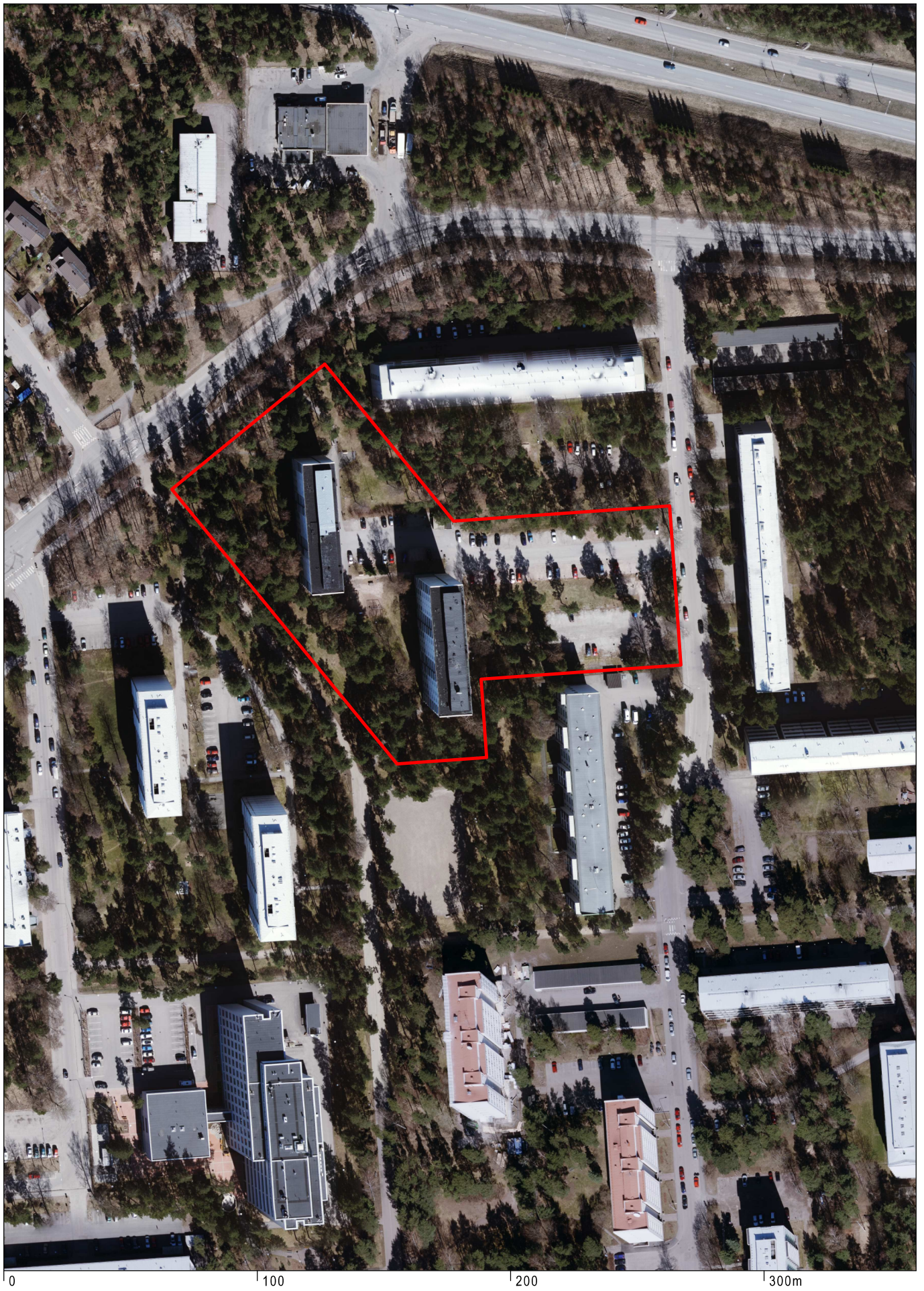
Ilmakuva Myllypuro Tuulimyllyntie 3
