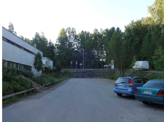
Laajennuksen sijoituspaikka, näkymä takapihan puolelta kohti Prinsessantietä
