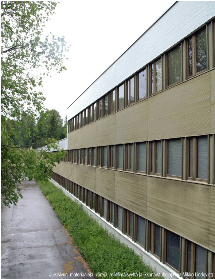
Julkisivun materiaaleja, värejä, reliefimäisyyttä ja ikkunanauhoja (kuva Mikko Lindqvist)
