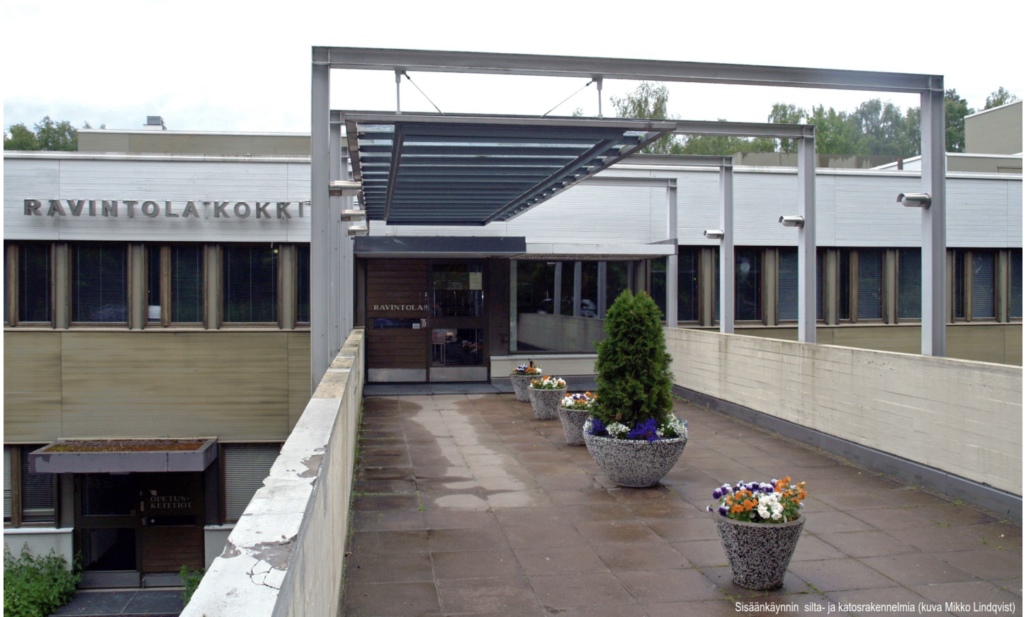
Sisäänkäynnin silta- ja katosrakennelmia (kuva Mikko Lindqvist)
