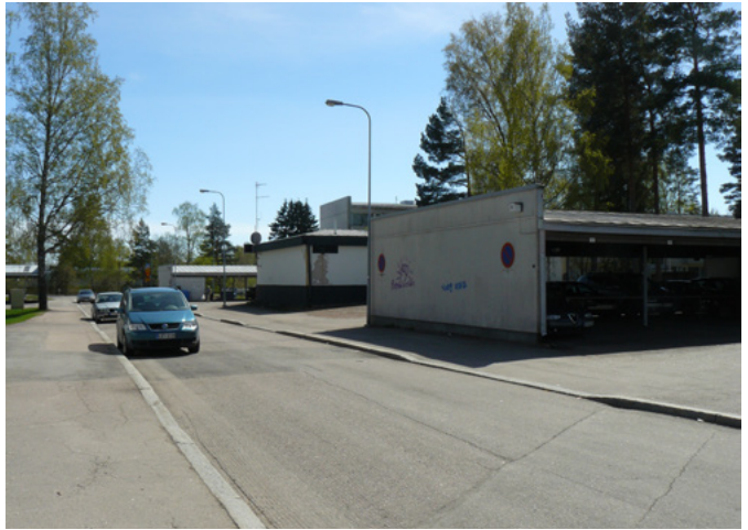
Olemassa olevat autokatokset, välissä purettava liikerakennus
