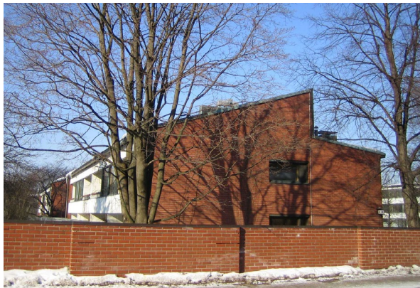
KORPPAANTIE 8, arkkitehti Eino Tuompo 1959.
