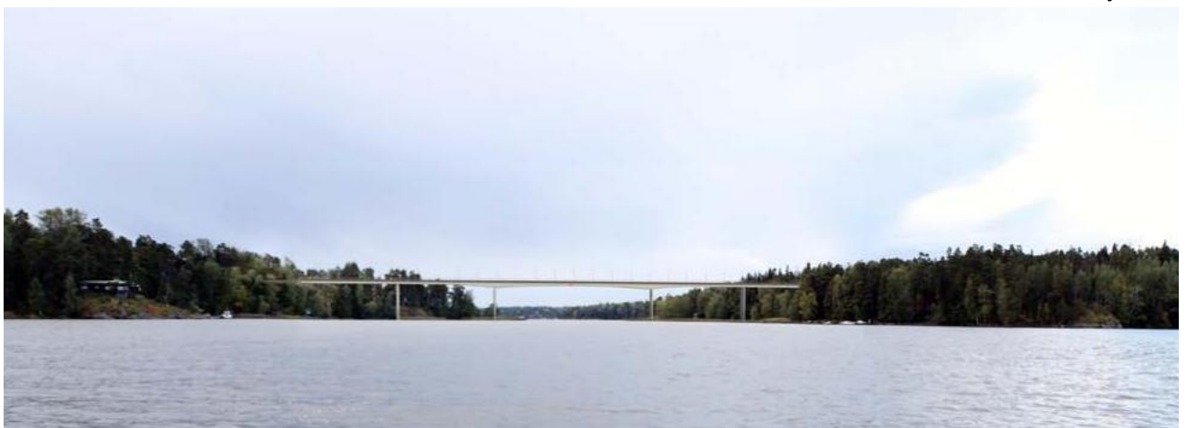
Ramsinsalmensilta, 2012, Fundatec Oy, Ksv.
