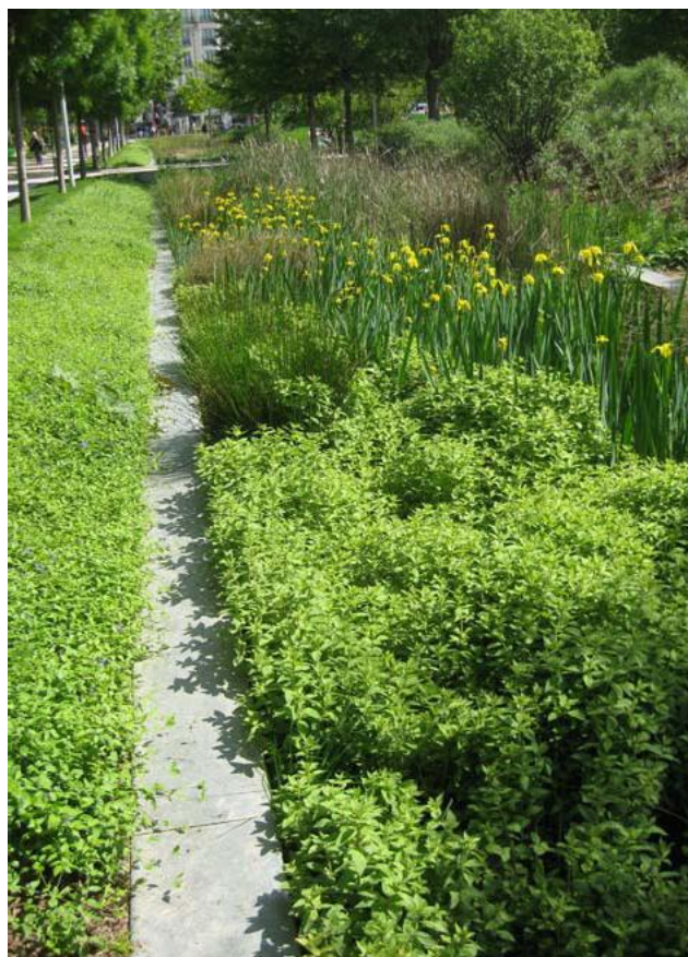
Hulevesipainanne kasveineen, N Strengell, Ksv.
