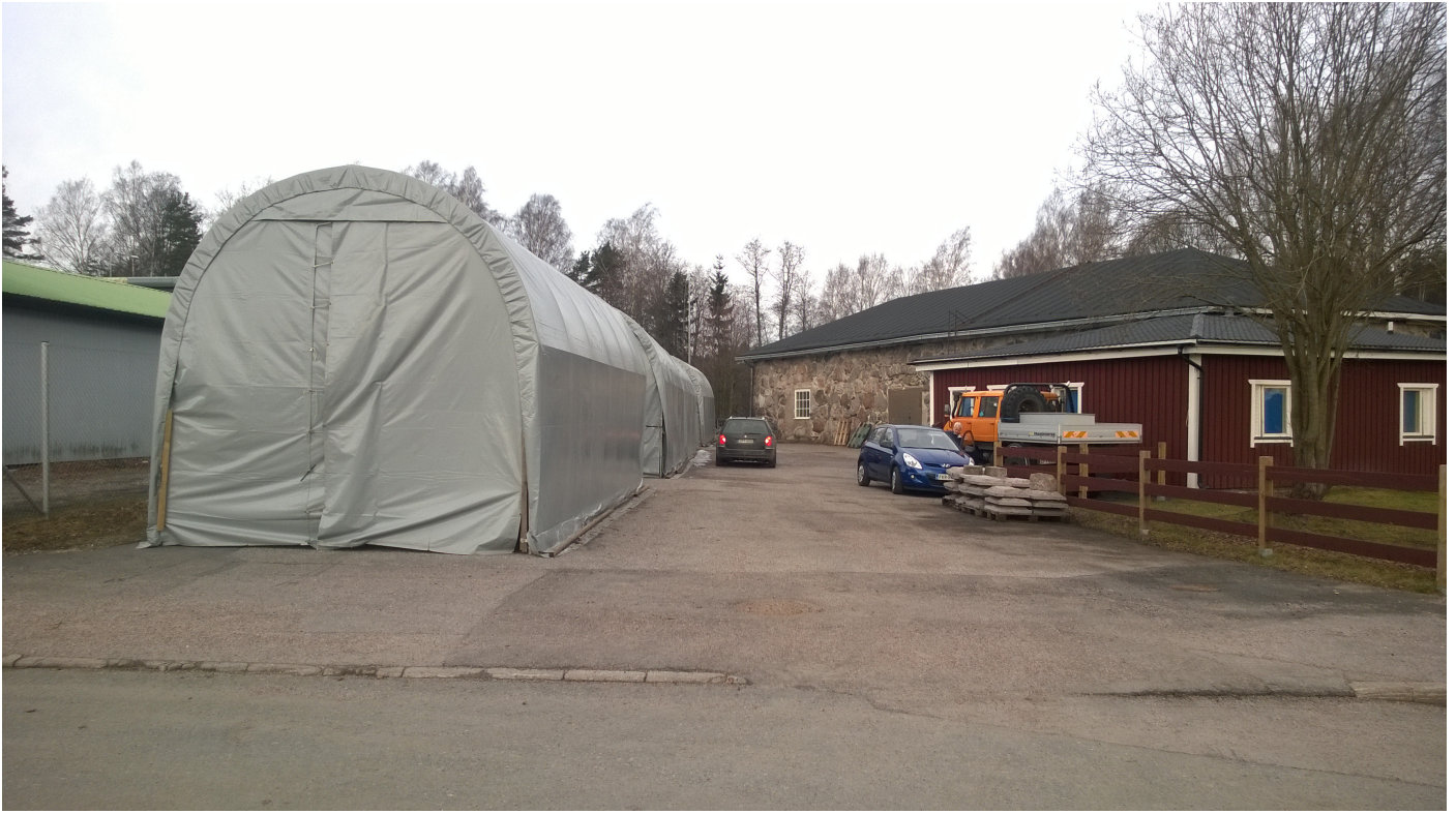
Näkymä Linnanherrankujalta rakentamattomalle Linnankujalle ja tontille, suojeltu kivimakasiini näkyy taka-alalla
