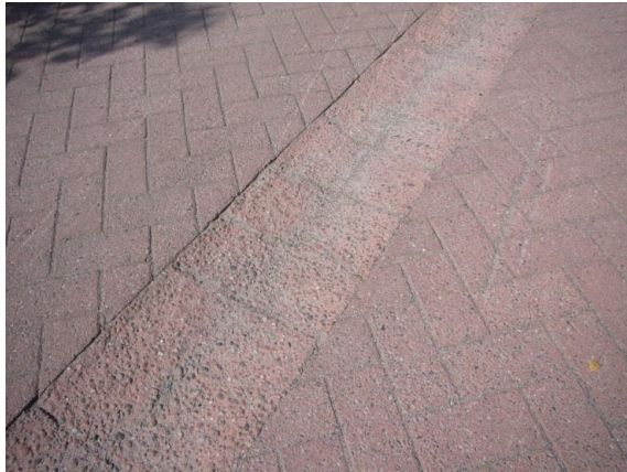
Kuva 39. Kiveykset, reunakivet ja istutuslaatikot ovat kuluneita ja kolhiintuneita.
