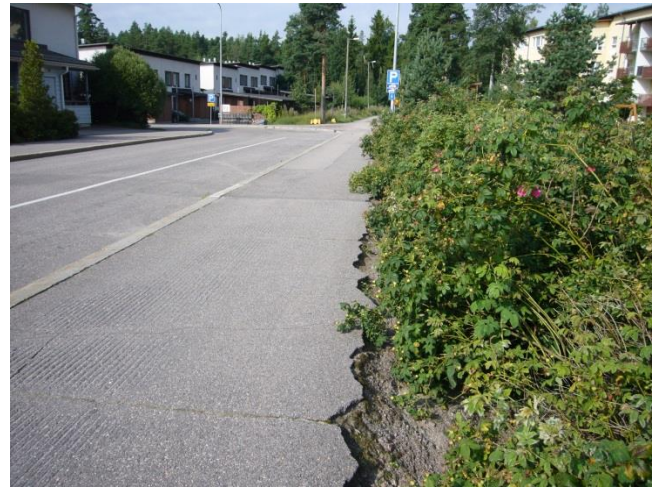
Kuva 37. Hallainvuoren jalkakäytävän reuna on pahoin murtunut.
