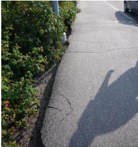
Kuva 37. Hallainvuoren jalkakäytävän reuna on pahoin murtunut.
