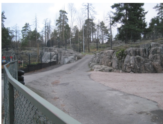
Kuva 14. Asukaspuistossa on käynnissä mittava peruskorjaus, joka lähti liikkeelle tarpeesta rakentaa aidat kallioille.
