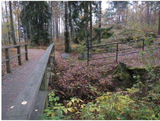
Kuva 43 Korkeakallion puistossa oleva suoja-aita katkeaa juuri ennen siltaa.
