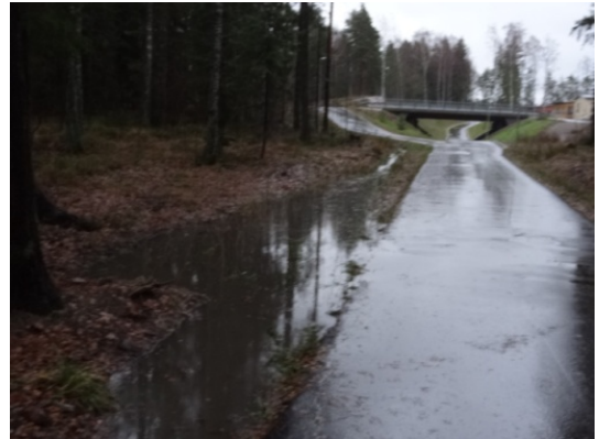
Kuva 49. Höyrymyllynkujan kuivatusongelma.
