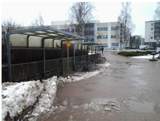
Kuva 45. Metroaseman pyöräkatokset ovat epähoukuttelevia ja paikoin katokset ovat hajonneita.
