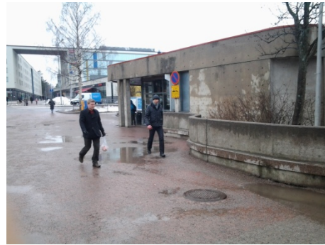
Kuva 4. Metroaseman sisäänkäynti kaipaisi kunnostusta.
