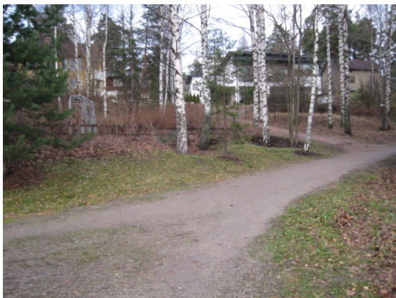
Kuva 35. Karhunkaatajantien peruskorjauksessa oleva raitti.
