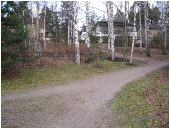
Kuva 31. Karhunkaatajantien peruskorjauksessa oleva raitti.
