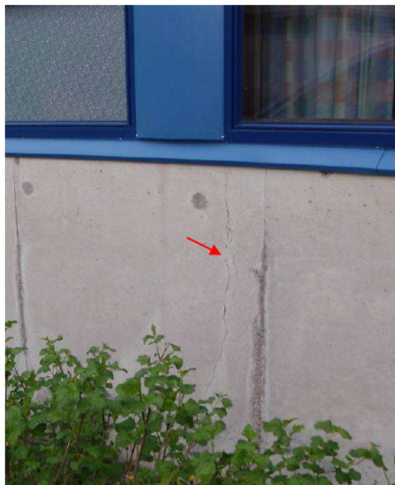
Kuvat 1 ja 2. Betonielementin ulkokuoren halkeamia.
