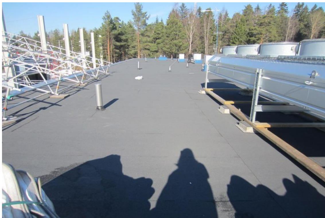
Kuva 6: Vesikate on silmämääräisesti arvioiden hyväkuntoinen.
