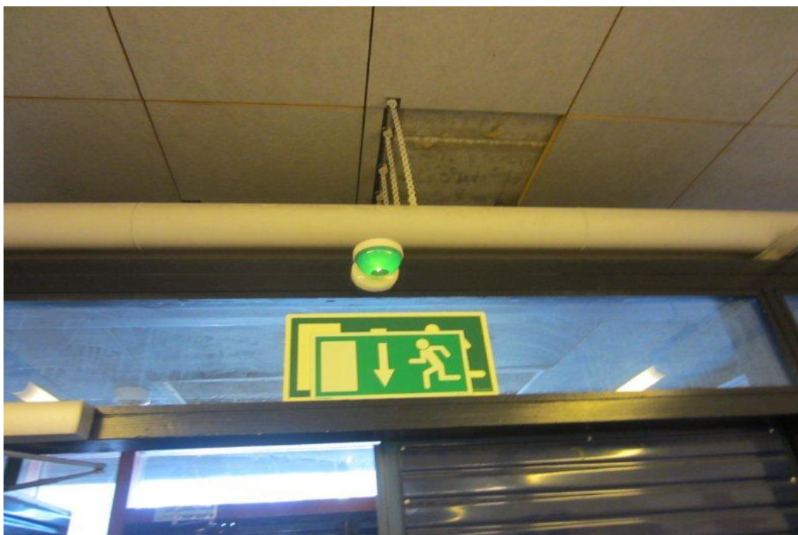
Kuva 6: Kuvassa on vanha poistumistien ovimerkkivalaisin. Koko järjestelmä on uusimisen tarpeessa.
