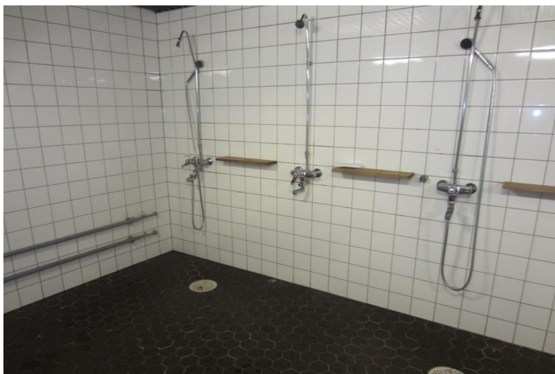
Kuva 7: Rakennuksen märkätilat ovat rakenteiltaan alkuperäisiä.
