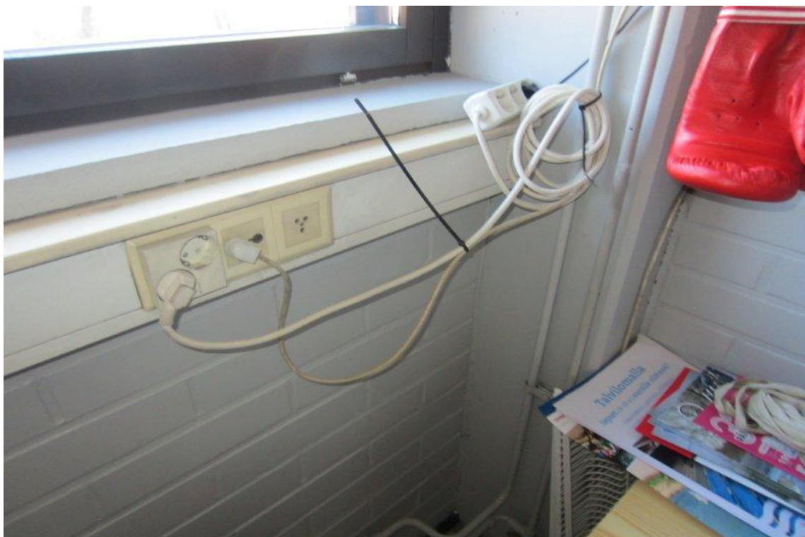
Kuva 4: Johtokanava-asennukset ovat alkuperäisiä.
