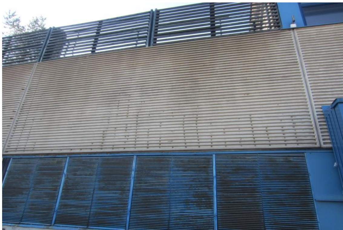
Kuva 5: Julkisivun korroosiovaurioita.
