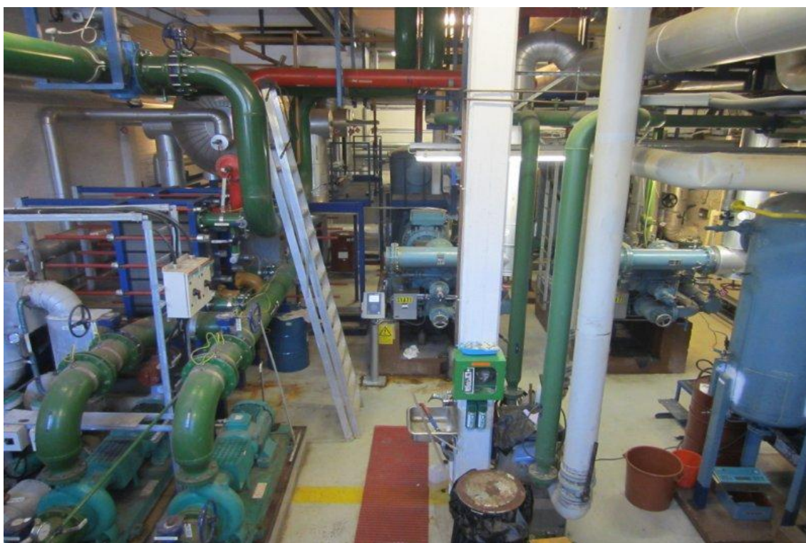
Kuva 10: Kaikki rakennuksen jäähdytyslaitteistot palvelevat tekojäärataa ( ei sisällytetty kuntoarvioon).
