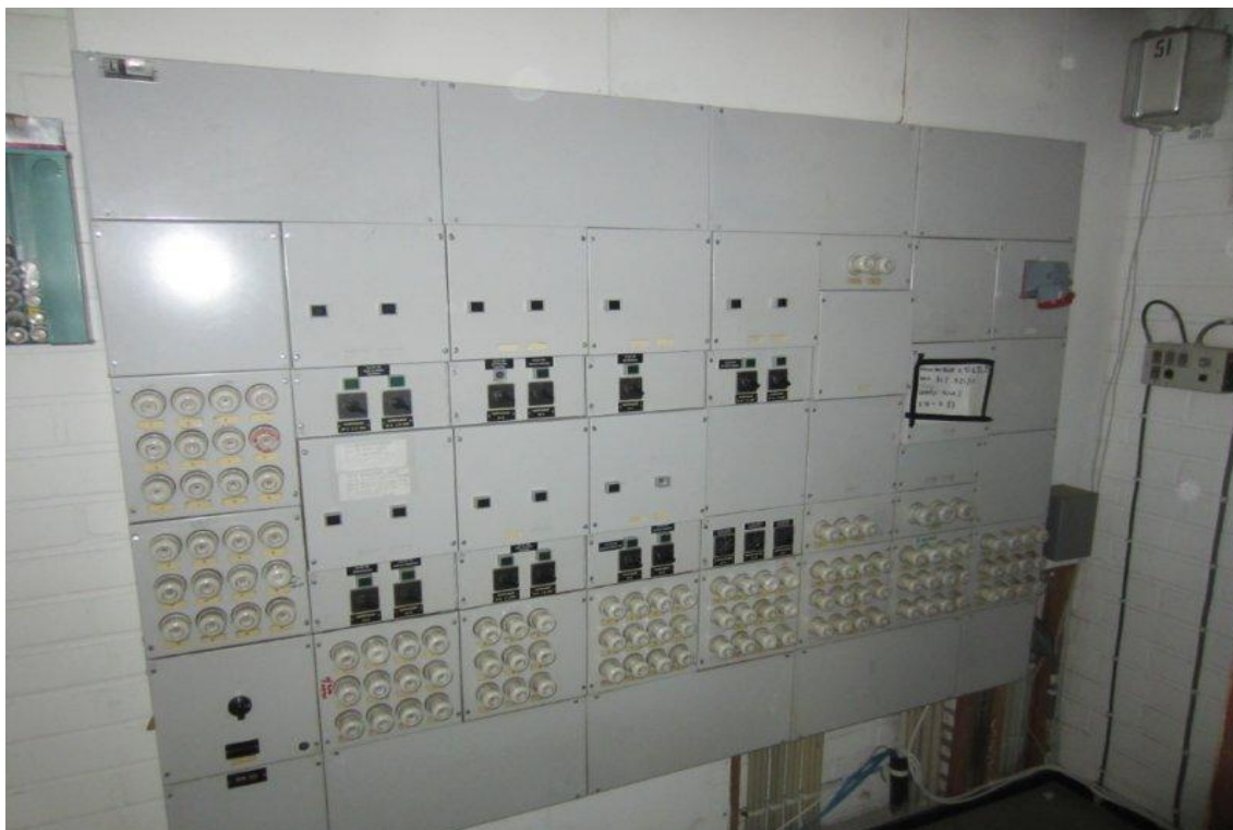
Kuva 1: Ryhmäkeskukset ovat alkuperäisiä 1970-luvulta ja ne alkavat olla uusimisen tarpeessa.
