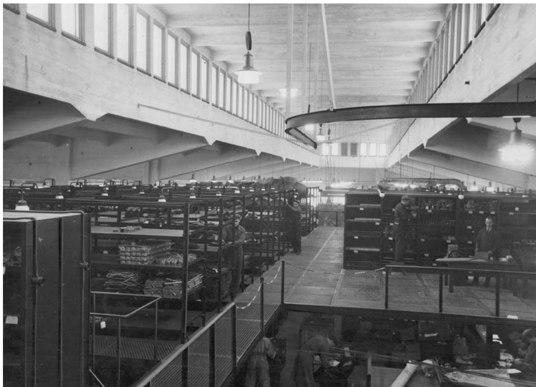
2. kerros, kattolyhty varaosavarastona.FORD, MOBA
