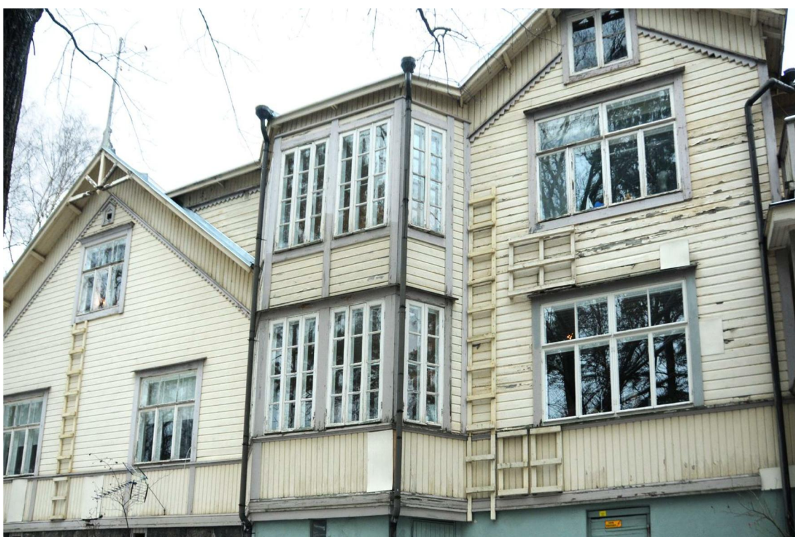
Kuva 14 Kunnostettavia hätäpoistumistietikkaita.
