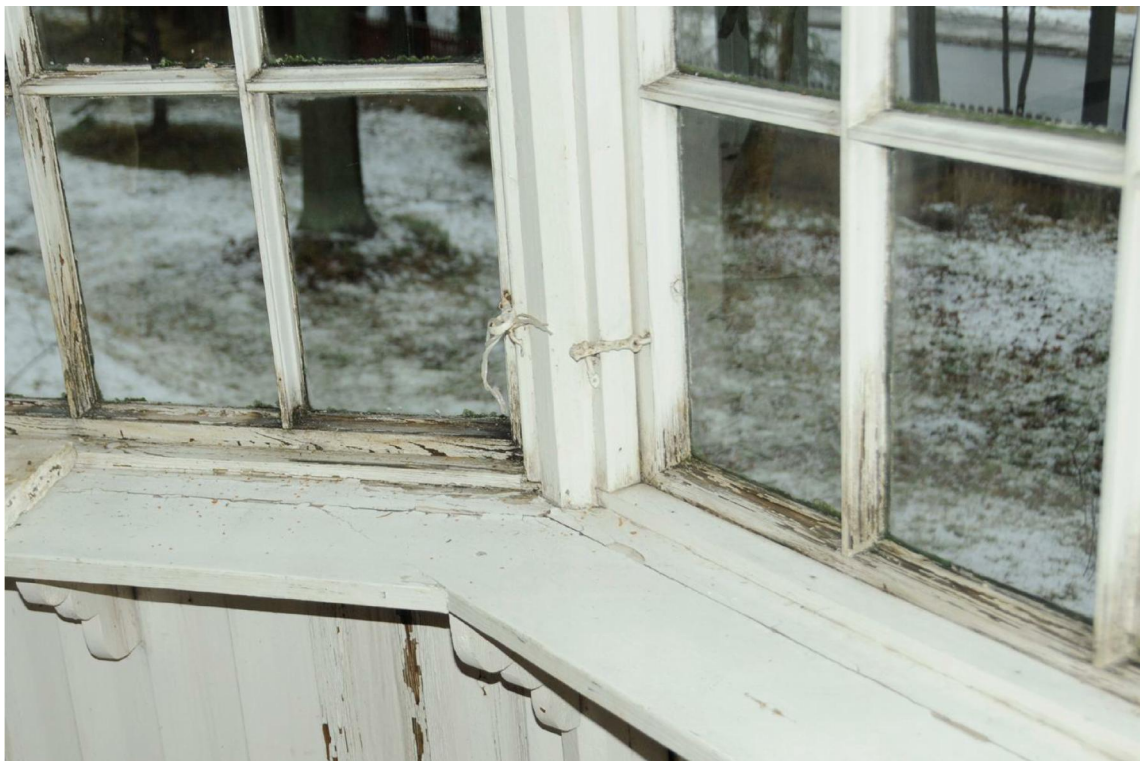
Kuva 11 Esimerkki yksinkertaisista kunnostettavista ikkunoista.
