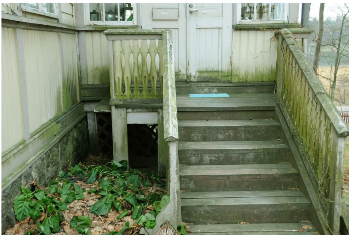
Kuva 6 Sammaleen tai levän peittämää portaiden rakennetta.
