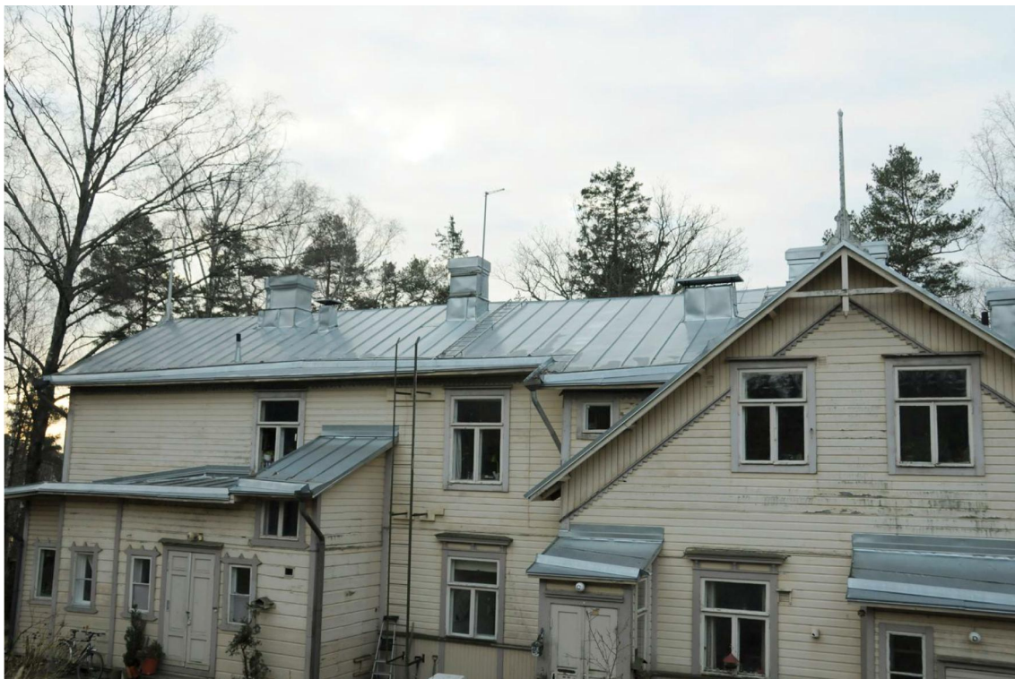
Kuva 13 Maalattavaa peltikattoa.
