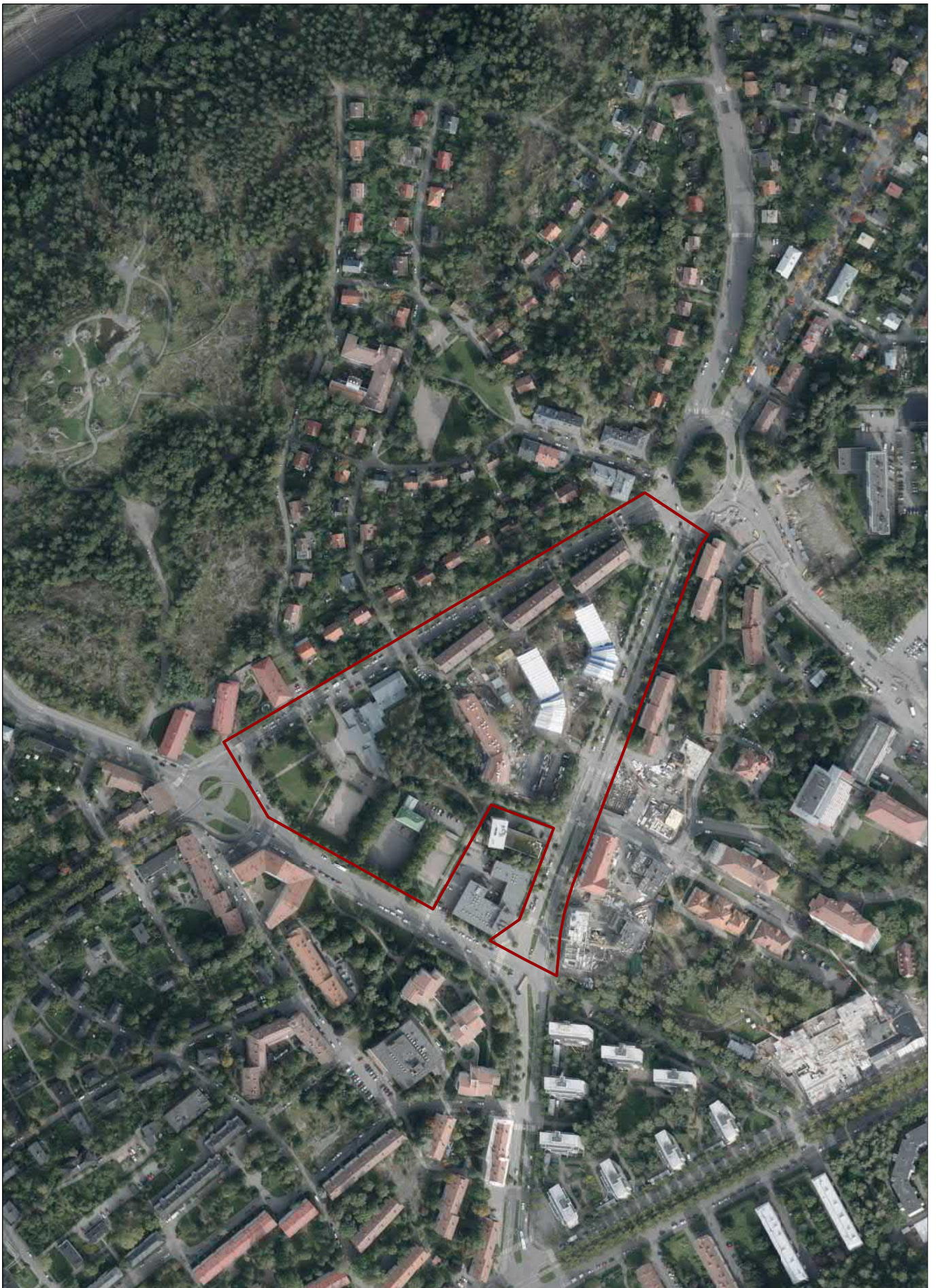
Ilmakuva Pohjolankatu 45 ja 47
