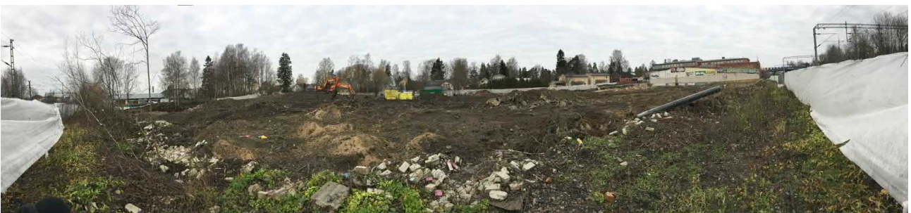
Panoramakuva purkutyömaa-alueen eteläpäädyistä pohjoiseen.
