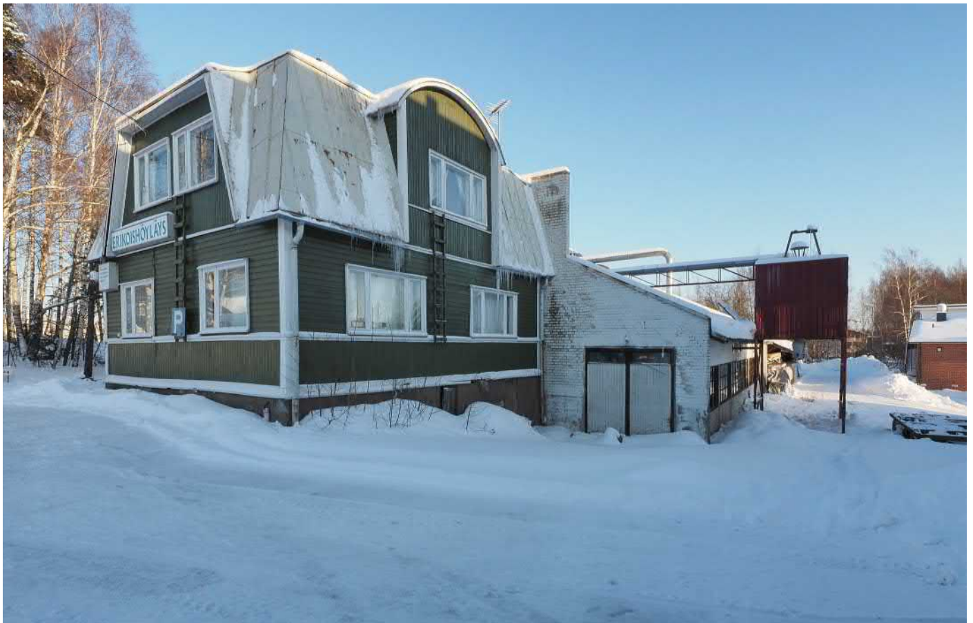
Rakennus kuvattuna lännestä
