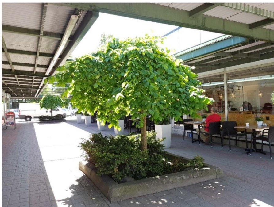
Erillisiä paviljonkirakennuksia yhdistävillä katoksilla on merkittävä rooli Munkkivuoren ostoskeskuksen arkkitehtuurissa.
