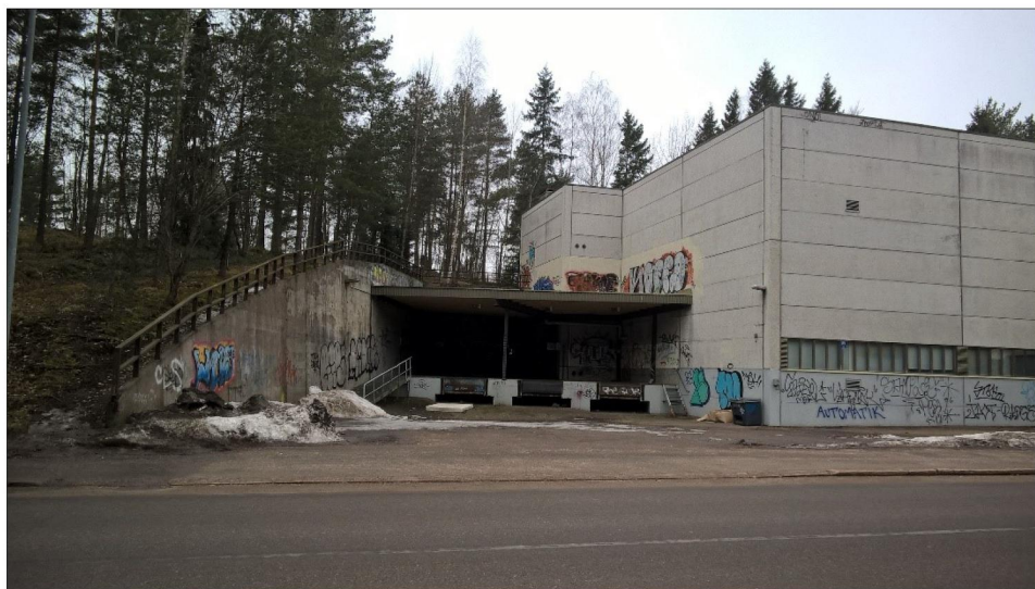
Isku Invest Oy:n tyhjilleen jääneen varastorakennuksen tontti on louhittu kallioon.
