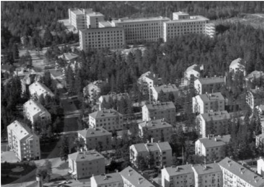
RUSKEASUON VIISTOILMAKUVA VUODELTA 1955 INVALIDISÄÄTIÖ PÄÄRAKENNUSTAUSTALLA
