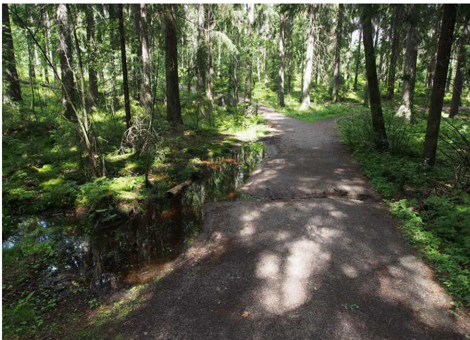
Ongelmakohdissa käytävien kuivatusta parannetaan uudella rumpuputkella.
