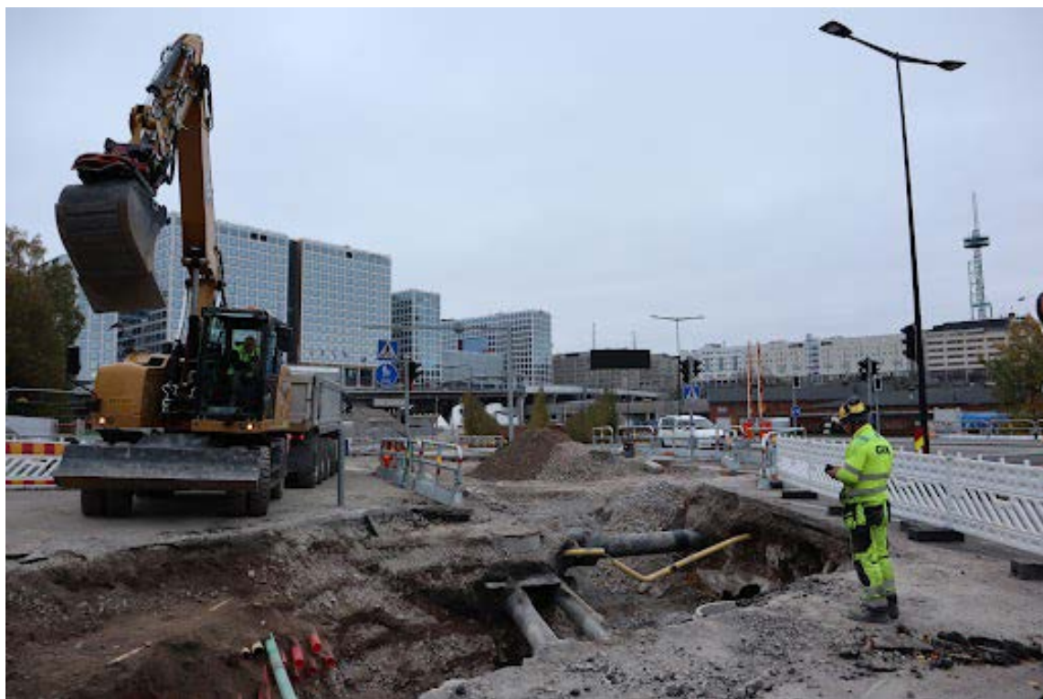
Kuva 28. Veturitien työmaa Pasilassa
