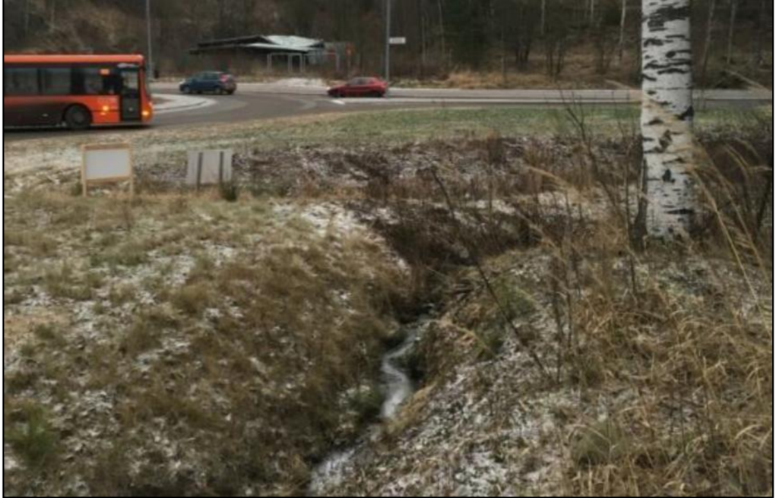
Kuva 9. Viikintien ja Viilarintien kiertoliittymän vieressä oleva painanne, josta kaava-alueen vedet siirtyvät eteenpäin tiet alittavissa viemäreissä.
