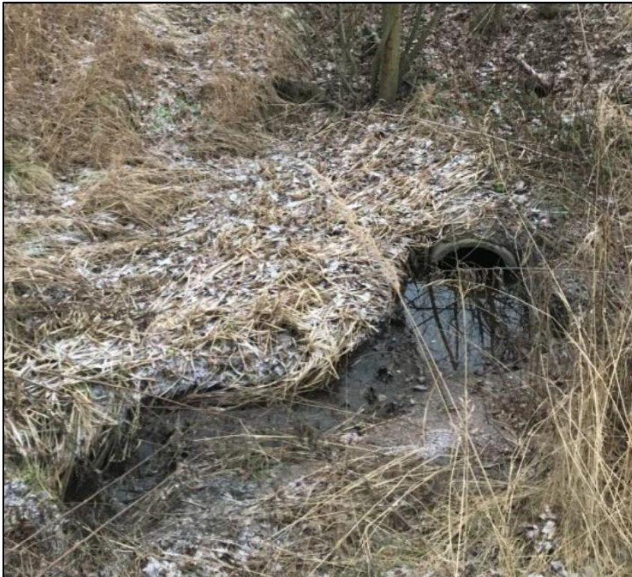
Kuva 7. Länsi-Herttoniemen suunnasta tulevan hulevesiviemärin purku ennen Viikintien alitusta.
