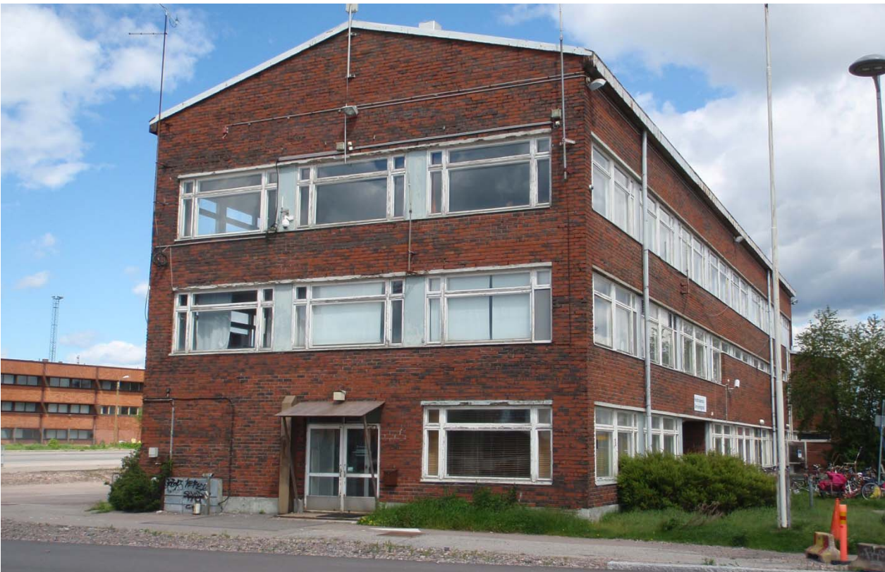
Huoltorakennuksen julkisivu lounaaseen ja osa kaakkoisjulkisivua.
