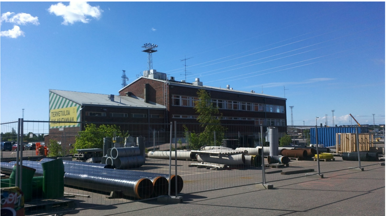
Huoltorakennuksen julkisivu luoteeseen ja osa koillispäätä.
