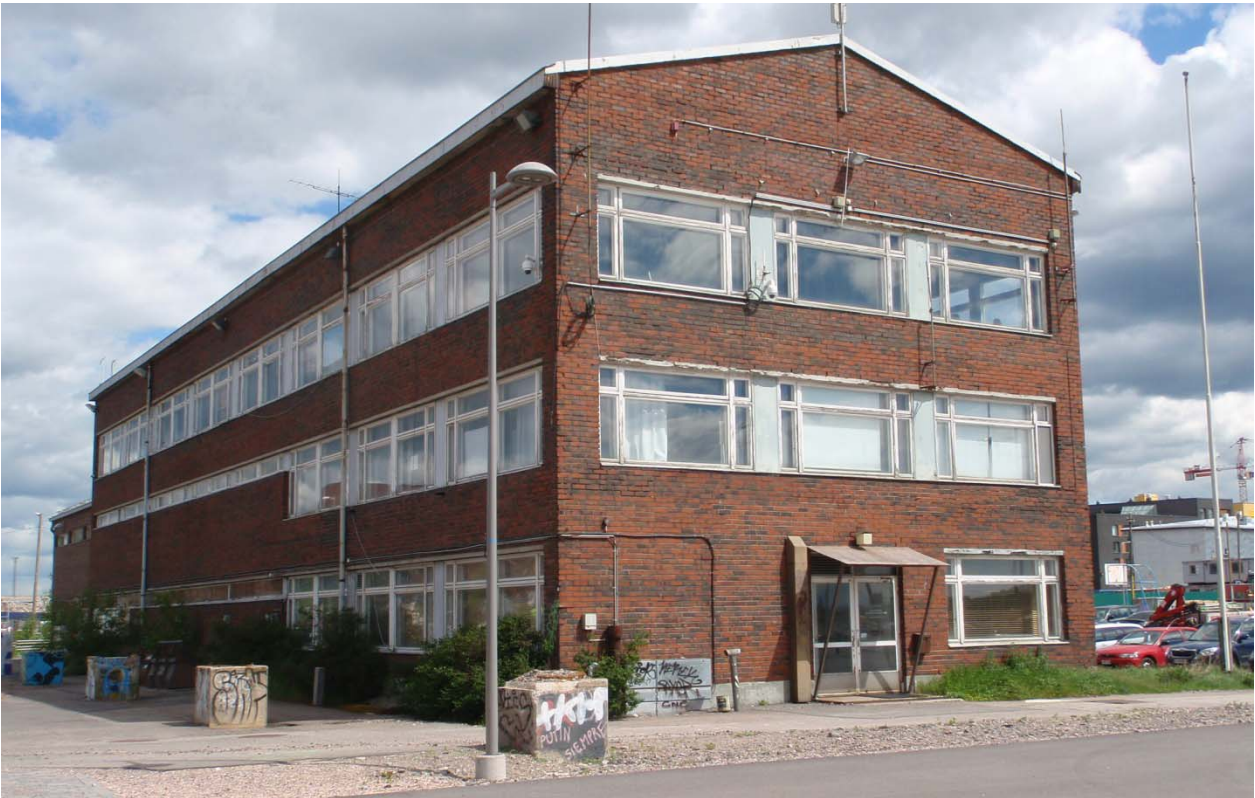
Huoltorakennuksen julkisivu luoteeseen ja lounaaseen.
