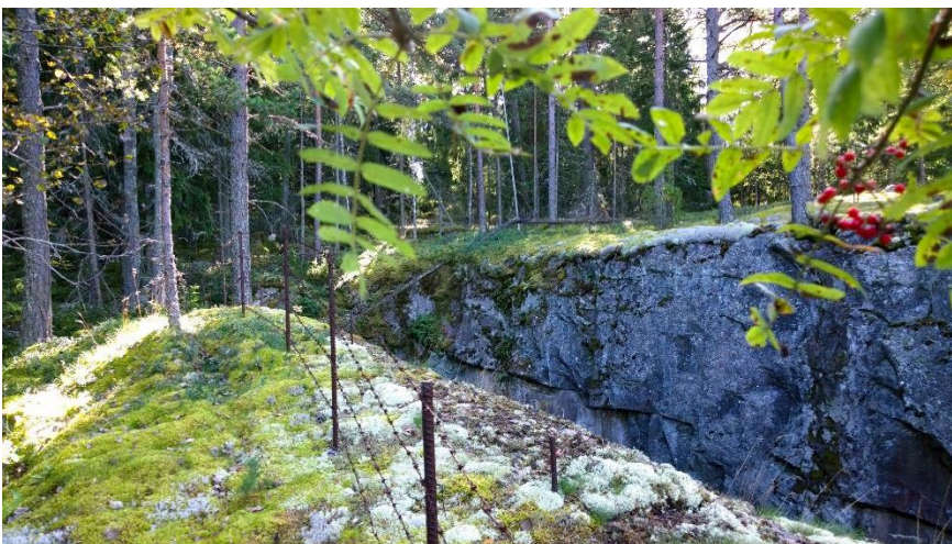
AKDG 4877:87. Itä-Villinki, varuskunnan suojatunnelit. Kuvaaja: S. Koivisto.
