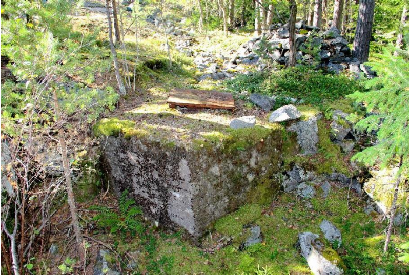
AKDG 4877:154. Itä-Villinki, kaapelikaivo. Kuvaaja: J. Lagerstedt.
