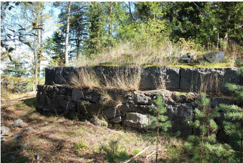
AKDG 4877:160. Itä-Villinki, rakennuksen perusta. Kuvaaja: J. Lagerstedt.
