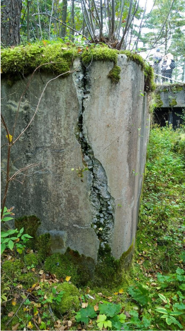
Kuva 13. Murenevaa betonirakennetta kevyen tykkipatterin rintasuojassa (vas.) ja kasvillisuuteen vähitellen peittyvä puhelinasema (oik.) saaren itäosassa. Kuvat: Satu Koivisto/ARKE (AKDG 4877:45 ja :126).
