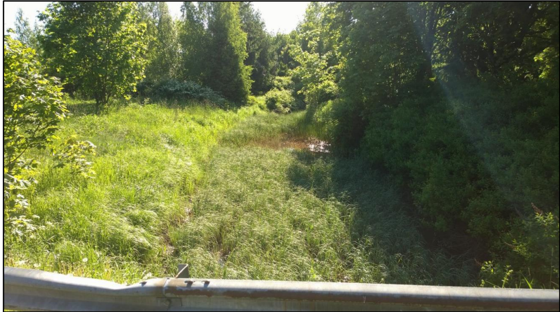
Kuva 16. Lentokentänojaa Tuiskutien-Elovalkeantien linjan alapuolella.
