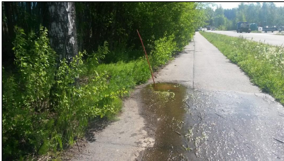
Kuva 12. Pohjavettä purkautuu kaapelikaivosta Jarrutiellä. HSY:n päivystyksen tiedon mukaan kohteesta tulee usein ilmoituksia.
