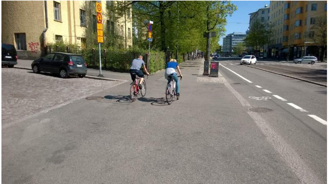
Yksi uusista Helsinginkadun jalankulkua suosivista liittymäjärjestelyistä. Suojatie on poistettu ja ajorata on nostettu jalkakäytävän tasoon.
