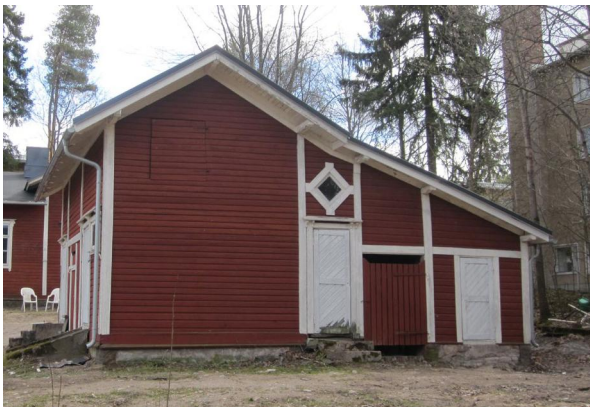
Vahtituvan talousrakennus, n. 1901. sr-2.
