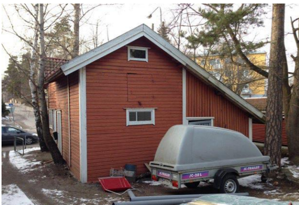
Vahtituvan talousrakennus, n. 1909. sr-2.
