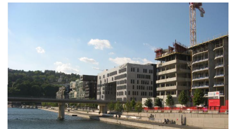
Rantarakentamista Lyonissa. Kuva: Tapani Rauramo
